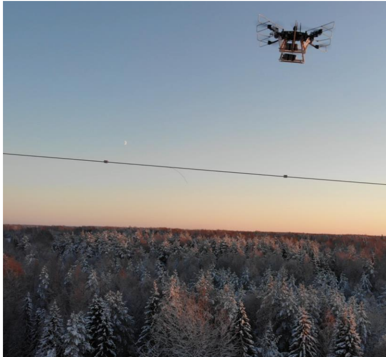
Установка ремонтных зажимов на расплетений грозозащитного троса ВЛ 220кВ Киров – Марадыково, декабрь 2021
