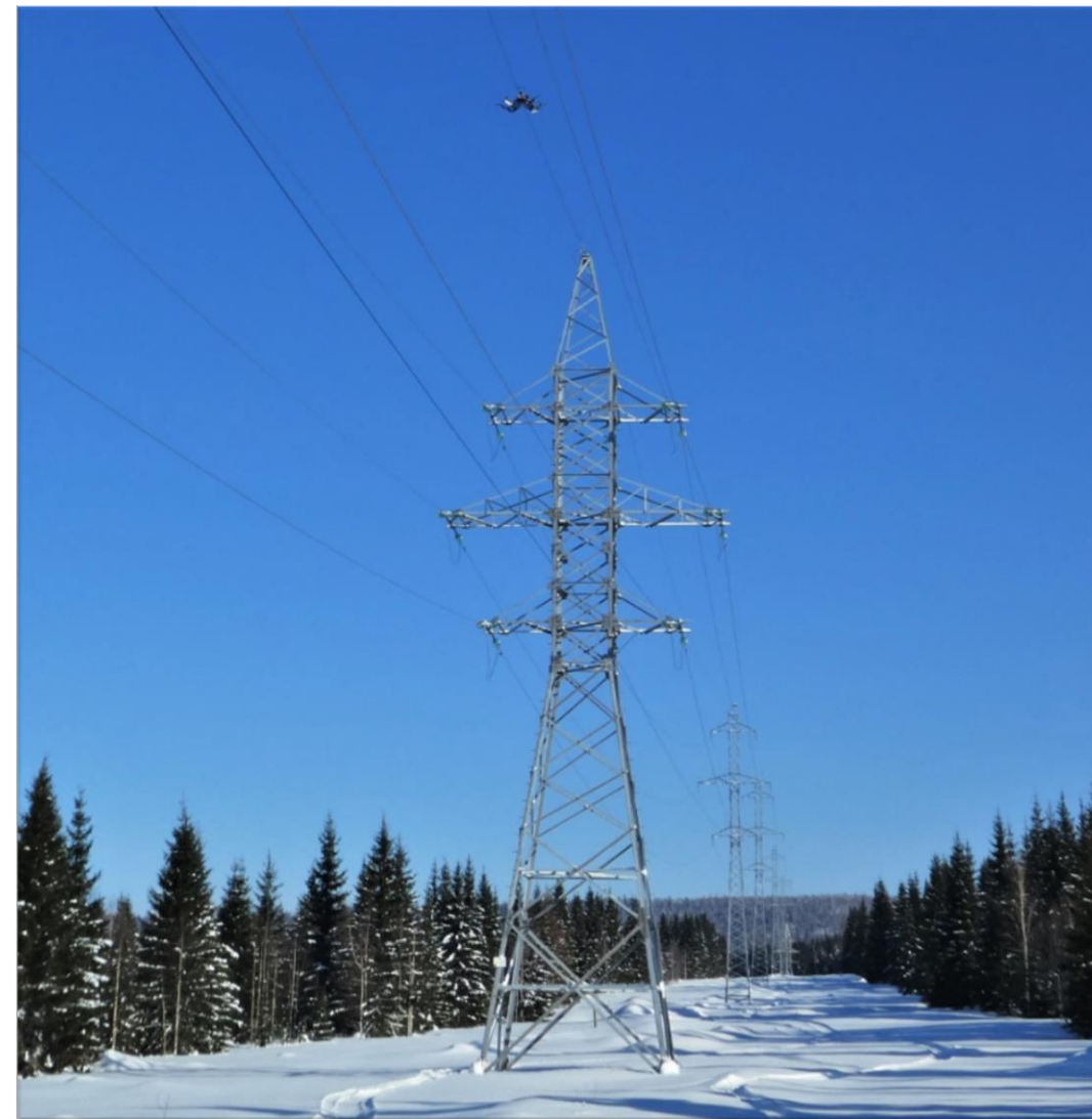
Смазка грозотроса ВЛ 35 кВ на Угольная – Усьва, 2021
