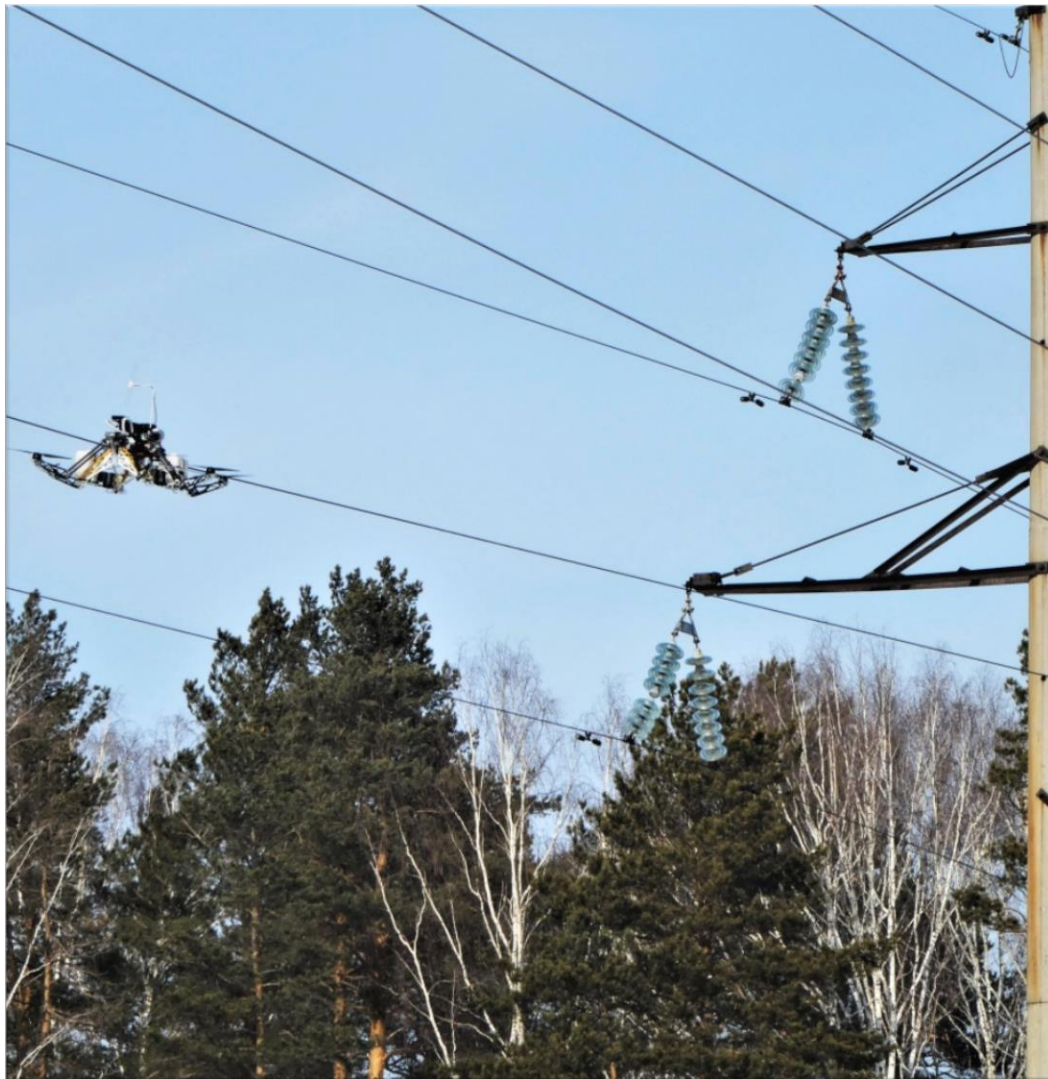
Смазка провода ВЛ 110 кВ на ПС Драга, февраль 2021
