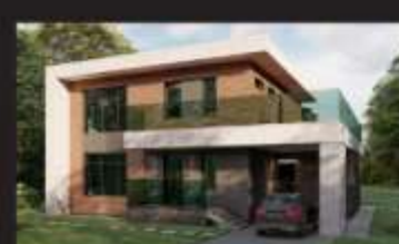
в процессе строительства Дом в Московской области 2021
