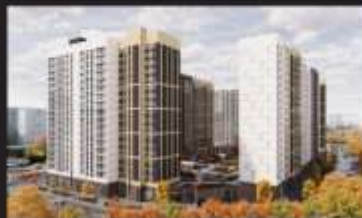
реализован Жилой комплекс со стилобатом Астрахань, 2023
