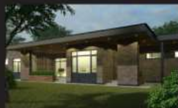
в процессе строительства Частный жилой дом Йошкар-Ола, 2021
