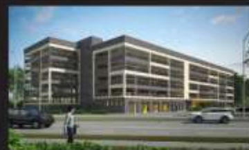
в процессе строительства Паркинг на 450 машино-мест Мурманск, 2021
