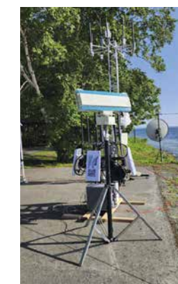
Оборудование компаний Ступор и АйТуБи (группа Экватор)
