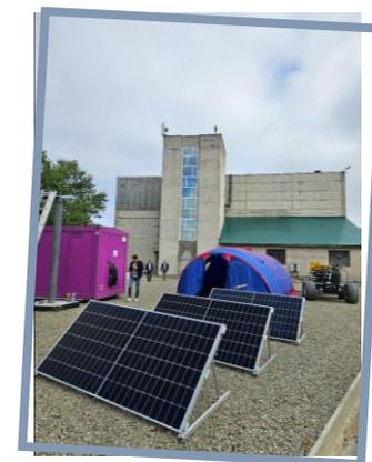
Источник энергии контейнерного размещения общей мощностью до **60 кВт** обеспечивает автономное питание полевого лагеря МЧС **в течение 10 дней**
