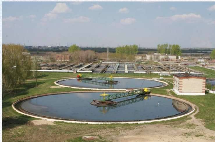
Рис. 7. Тюменские очистные сооружения
