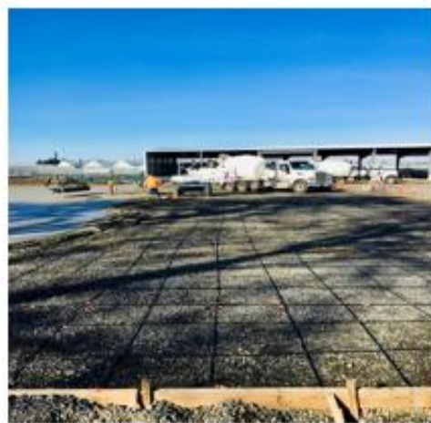
Вудберн, США Дорога и парковка 2018
