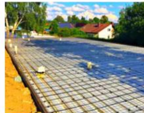
Дрезден, Германия Мост и дорога 2018
