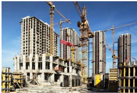
Стройка, подъемные работы
