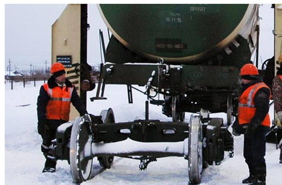
Сложности при замене КП с устройством диагностирования
