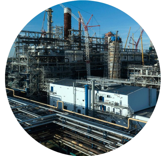
Мониторинг состояния конструкций
