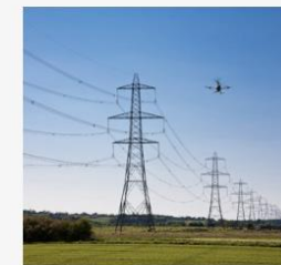
Оценка текущего состояния ЛЭП Съемка линий электропередач любой длины. Определение положения проводов. Детальный верховой осмотр.
