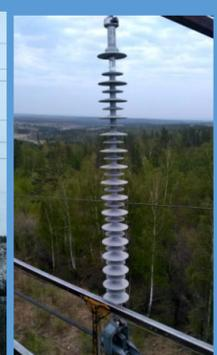
НИОКР 1 Линейные полимерные изоляторы ЛКи 70/110 УХЛ1
